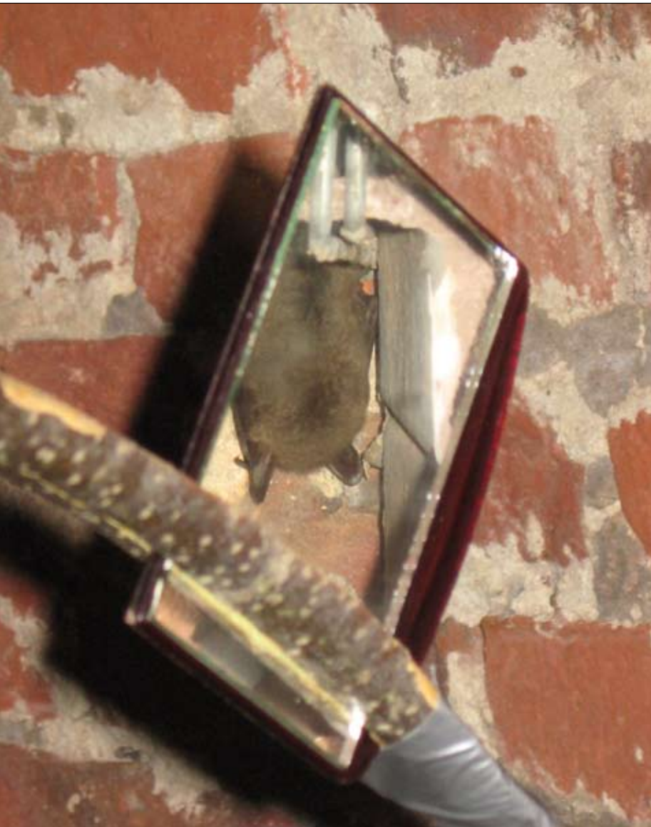
Figuur 13: Met behulp van een spiegelkje konden de holle bakstenen gecontroleerd worden: in deze steen overwintert een vleermuis ( Myotis spec. ). © RLD vzw
