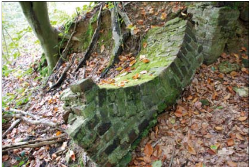
Figuur 3B: Detail van het onderdeel van het tongewelf van het ingestorte deel. © Ontwerpbureau Pauwels NV
