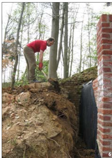
Figuur 4: Werknemers van MVG Vanderlinden metselen het ingestorte gedeelte van de ingang terug op. © RLD vzw
