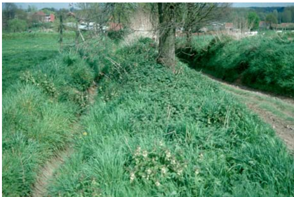
Schouder met greppel voor waterafvoer.
